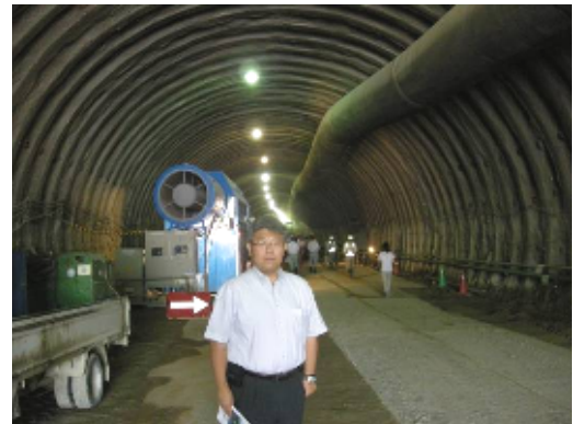
▲ 現在工事中の水源工区トンネル部
